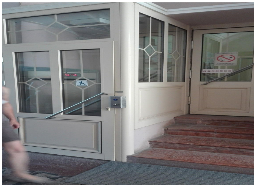
Слика 1 – Градска кућа Сомбор: пример подизне платформе која је једноставна за руковање, безбедна и добро уклопљена у архитектонско решење простора
